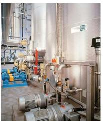
ALPHA-BIOTHERM<sup>®</sup> sludge pasteurisation plant
