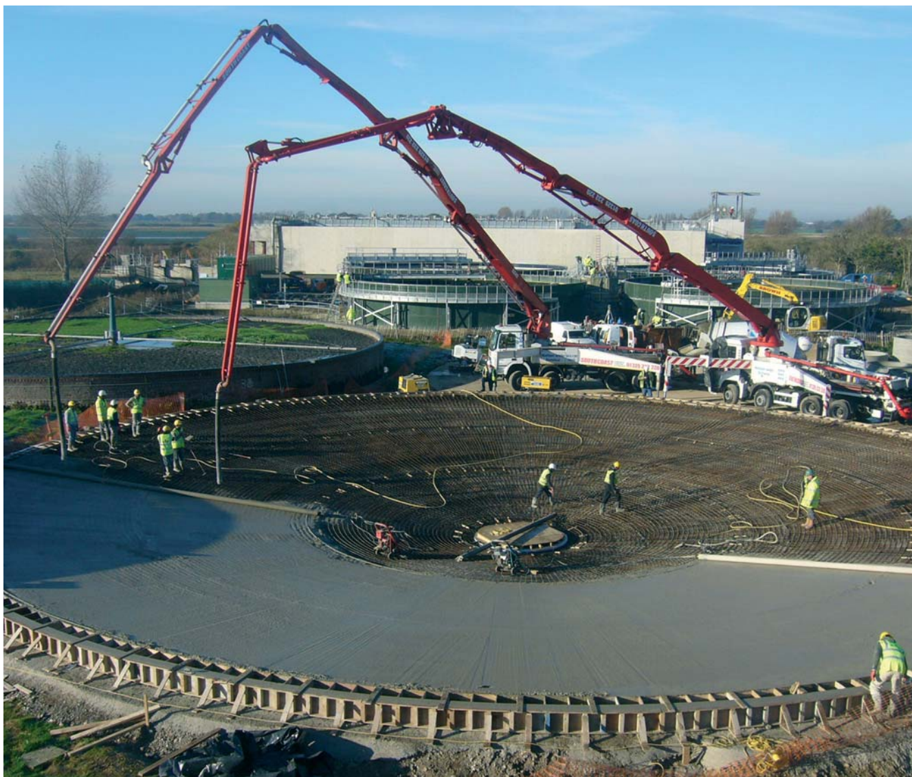
Final concrete pour
